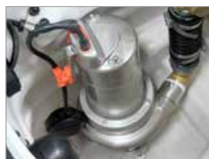
POMPE À IMMERSION HAUT RENDEMENT EN ACIER INOX POUR APPLICATION INDUSTRIELLE
